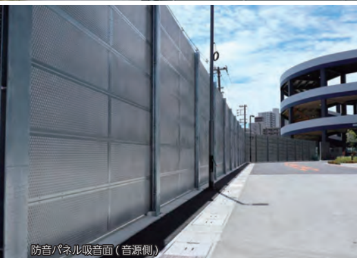
防音パネル吸音面 (音源側)
